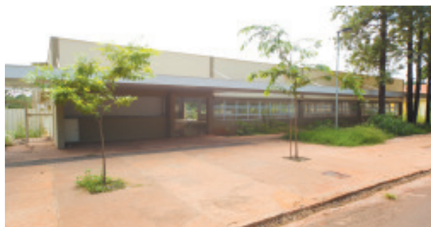
Fachada do novo restaurante
