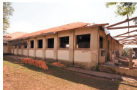
Início das obras da Central de Aulas
