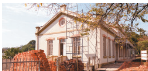
Substituição do telhado do Pavilhão Nicolau Athanassoff
