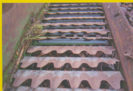
Uma camada de material anticorrosivo deve ser aplicada nas partes de maior uso
