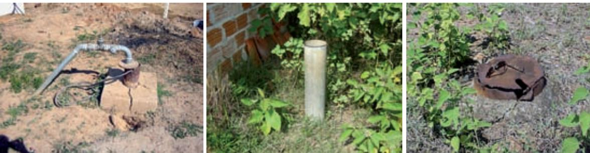
Poço com trinca na laje de proteção e tampa mal colocada.
