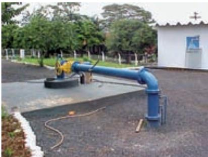
Ribeirão Preto (SP) – Poço tubular corretamente construído e protegido. Foto: Arquivo IG/SMA.
